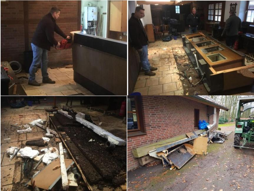
Mit dem Einbau der neuen Theke hatten wir uns zudem entschlossen, diese wie schon die Theke zu ganz früher Zeit wieder parallel zur Küche aufzubauen. Weiterhin nutzen wir die Chance und installierten direkt einen Abfluss im Boden, wobei mit erneut schwerem Gerät Fliesen über eine Länge von ca. 4 Metern hochgehoben wurden. Nach entsprechender Freilegung wurde neben dem Bodenabfluss auch der Abfluss von der Spüle gestaltet.
